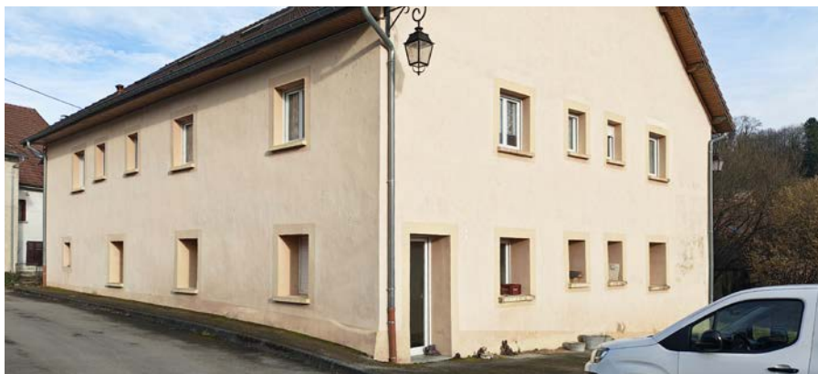
BEUTAL - Rue de la Crou - 10 logements.
